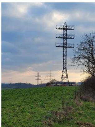
Dieses Leitungsprovisorium ist notwendig, um die Stromversorgung auch während der Bauarbeiten aufrechtzuerhalten. Die Leitung wird im laufenden Betrieb ausgebaut. In den kommenden Wochen plant Amprion mit den ersten Seilzügen, also dem Anbringen der Leiterseile an den Masten. Während der Bauphase ist weiterhin mit erhöhtem Baustellen- und Lieferverkehr zu rechnen.
